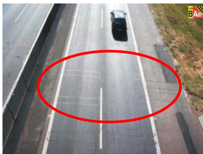
Figura III.2 - Sensores na pista Fonte: Empresa Engebrás
