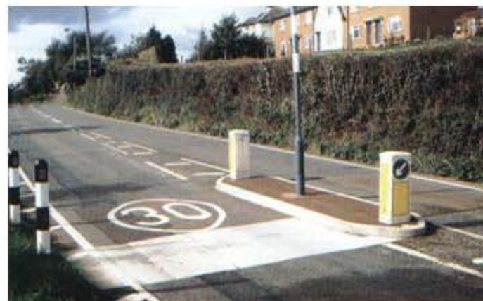
Fig.A.29 – ilha central e tratamento no pavimento
