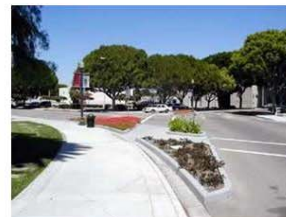
Fig.A.30 – Prolongamento do passeio
